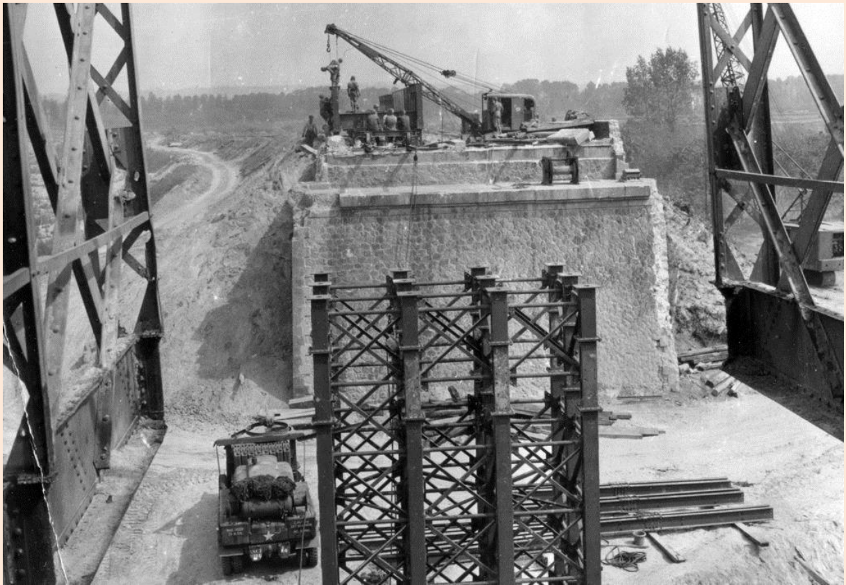
Image américaine prise à Pontaubault, par les reporters du Signal Corps, le 17 août 1944. Le 332ème bataillon du génie remet en état le pont de chemin de fer.
